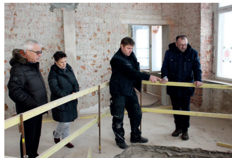
Ab 2004 stand das Gebäude leer, weshalb es in einem schlechten baulichen Zustand war.
